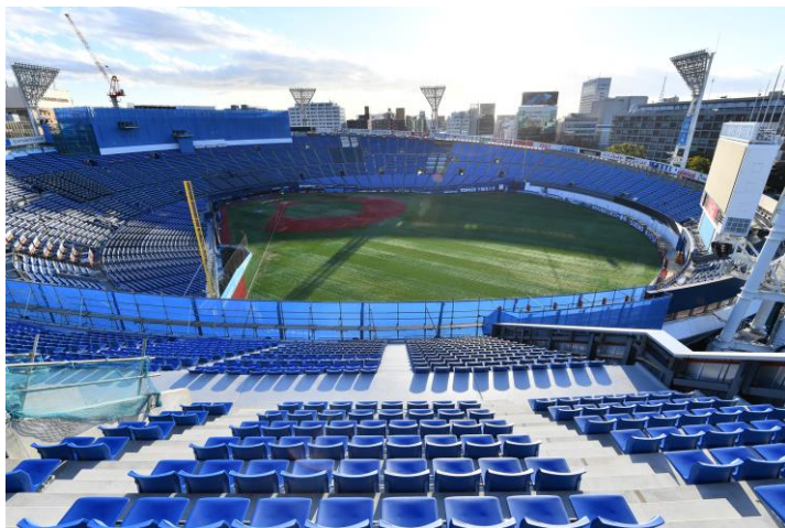
ライト側スタンド「ウイング席」からの眺望イメージ (2019年1月増築・改修工事中の写真)
